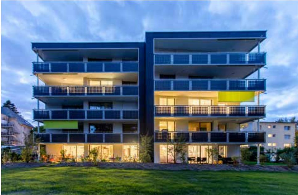
Neben dem Dach dienen im «Sonnenpark Plus» auch die Balkongeländer und Teile der Fassade zur Stromproduktion.
