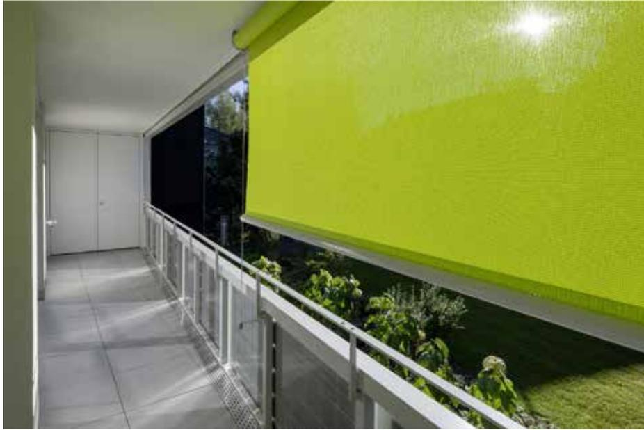
Auskragende Balkonplatten und aussenliegende Sonnenstoren schützen vor zu starker Erwärmung der Innenräume.
