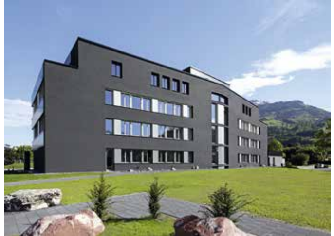
Die Nordwestfassade wurde mit einer Aussenwärmedämmung aus Steinwolle versehen.
