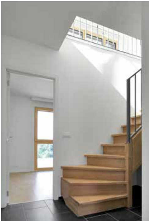
Die Mehrfamilienhäuser wurden mit Betonfertigteilen erstellt.
