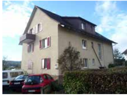
Das Mehrfamilienhaus vor der Sanierung.
