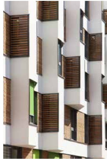
Fassadendetail mit Sonnenschutz.
