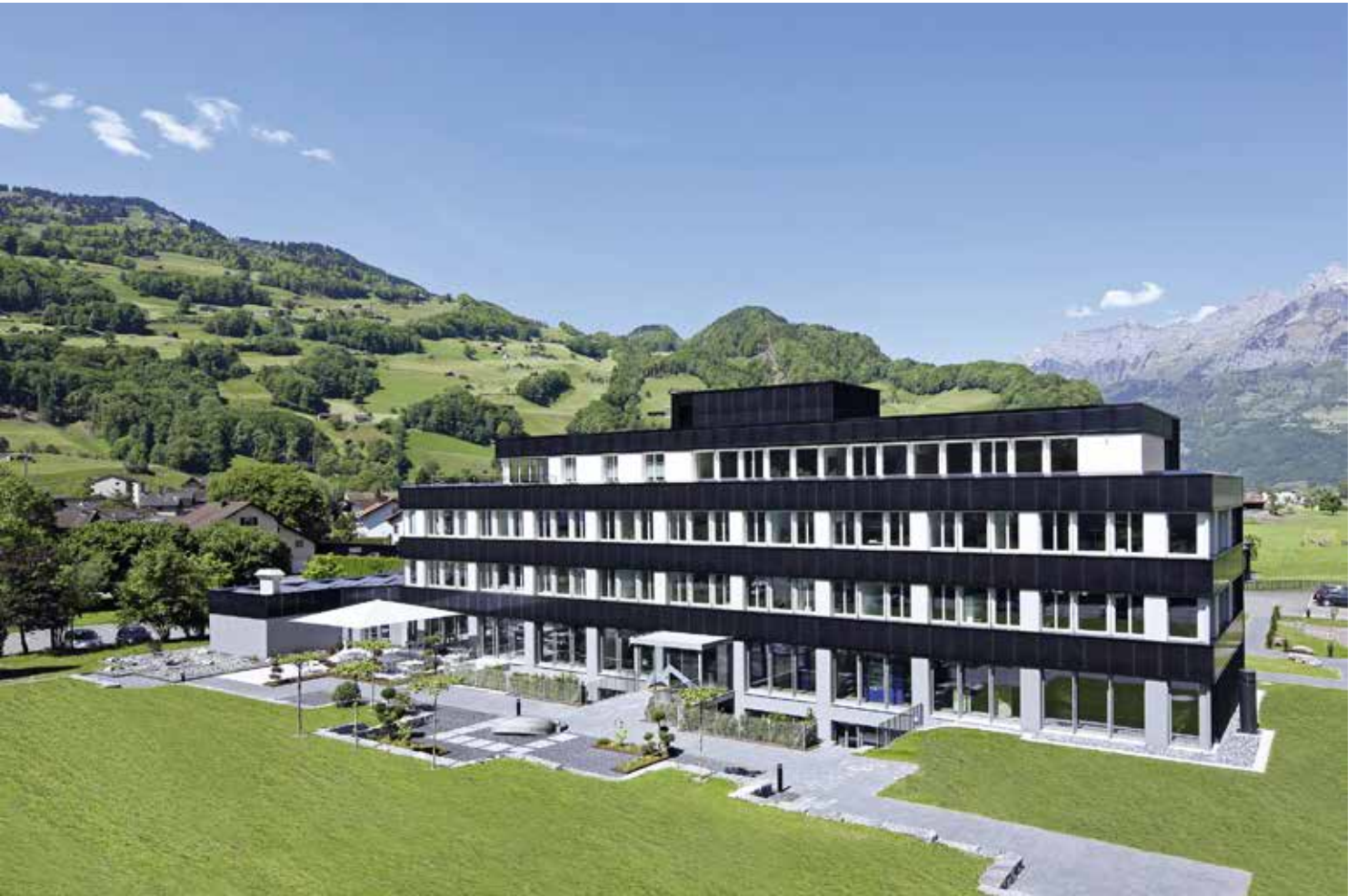
Die komplett neu gestaltete Fassade des Flumroc-Bürohauses mit Photovoltaikelementen. Architektur: Viridén + Partner, Zürich.
