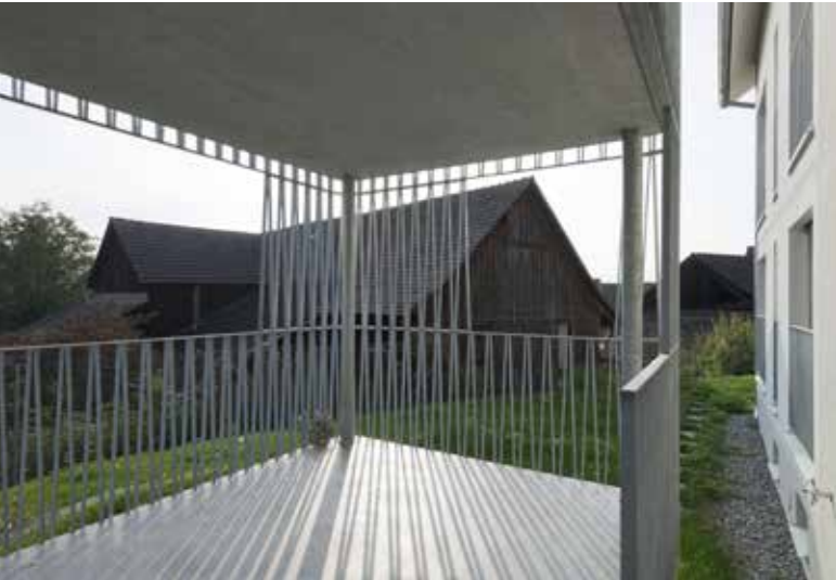
Die Balkone sind vom Haus abgekoppelt.
