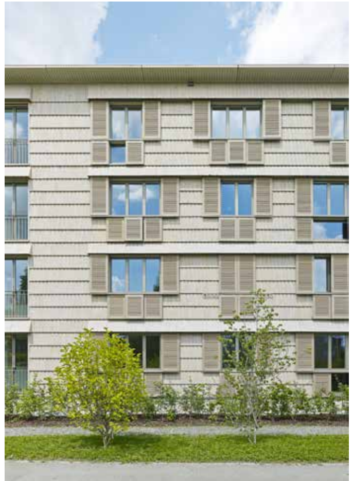
Solargläser unterhalb der Fenster speichern Wärme.
