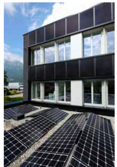
Auch die Dachflächen werden für die Stromerzeugung genutzt.
