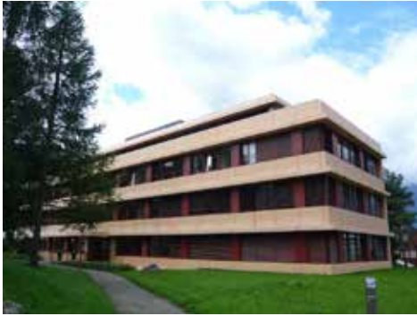
Das Bürogebäude im ursprünglichen Zustand.
