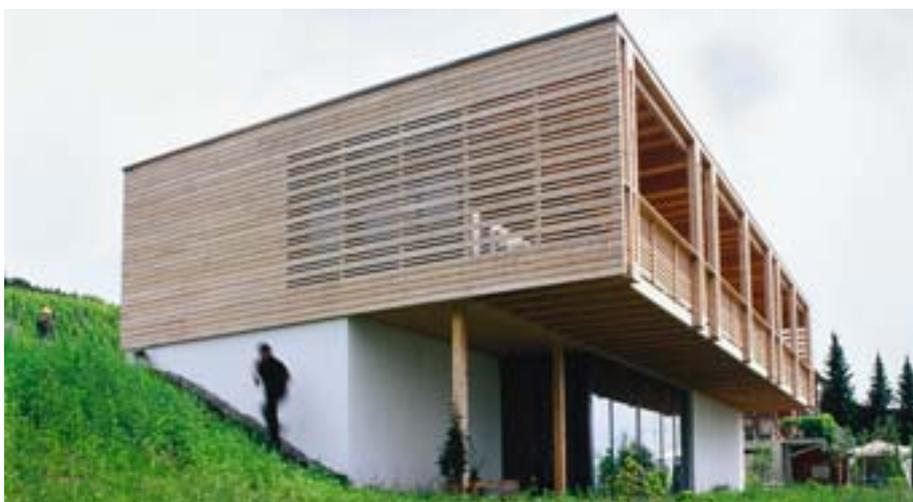
Gut gedämmt: die Aussenwände mit 40 cm und das Dach mit 42 bis 48 cm Zellulose
