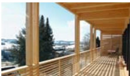
Der unter die Dachkonstruktion gehängte Balkon
