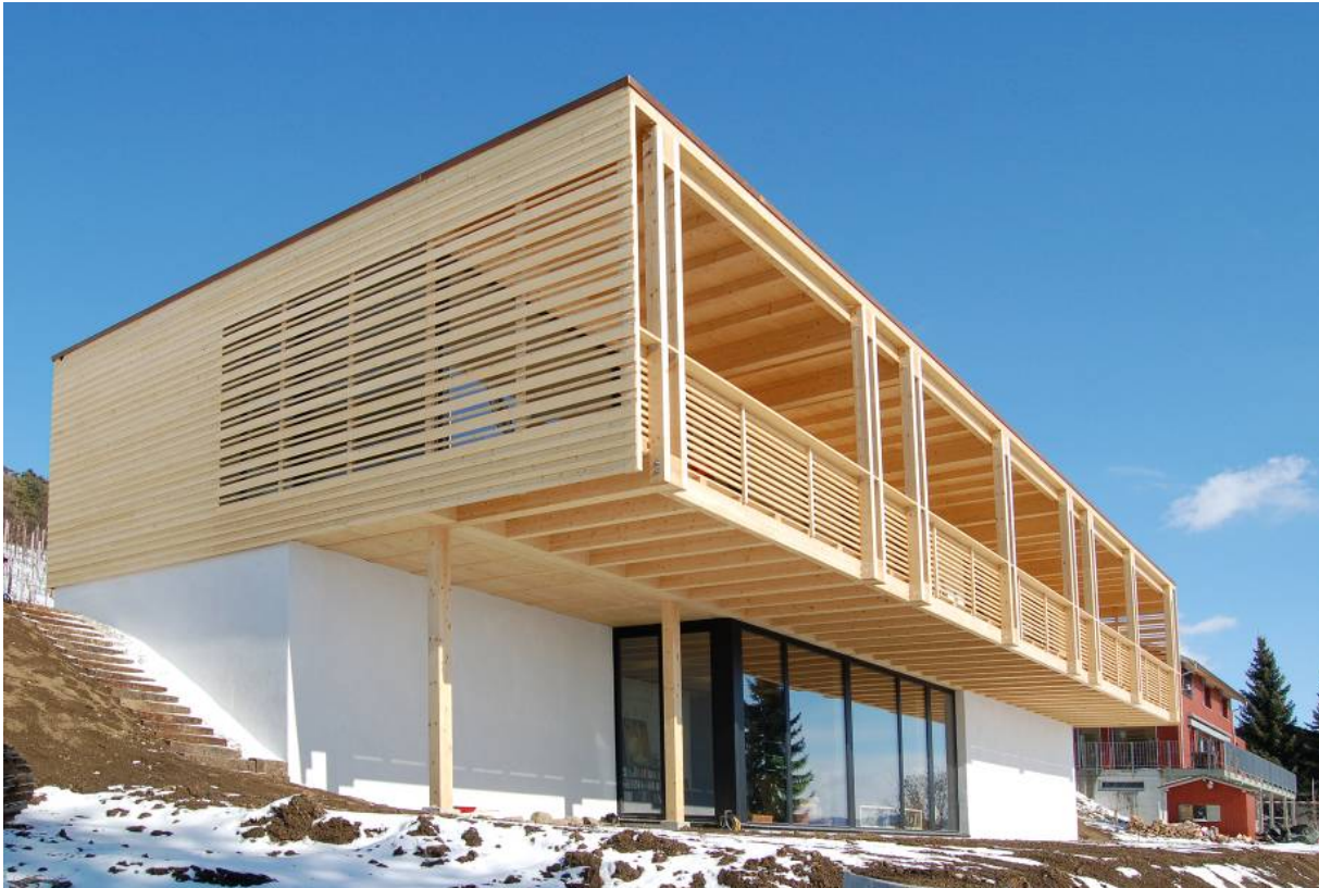
Objekt TG-003-P: Gelungene Kombinationen von Werkstoffen sind jederzeit möglich. Besonders Holzbauten werden oft umgesetzt. Bild: Bauatelier Metzler
