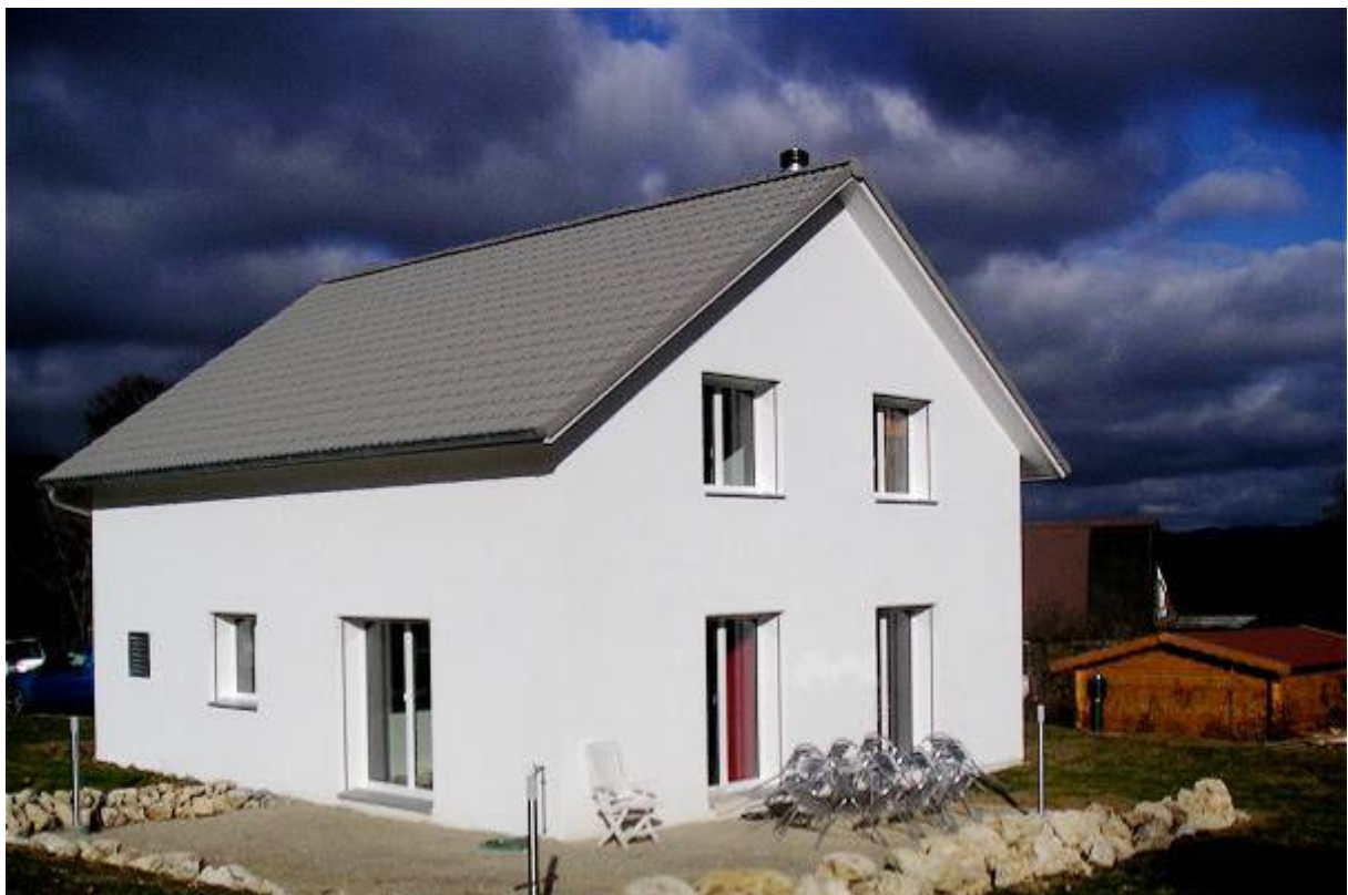
Objekt BE-012-P: Mit MINERGIE-P befindet man sich auch bei steigenden Preisen für fossile Brennstoffe auf der Sonnenseite.
