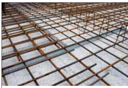
Eingelegte Dämmplatte
