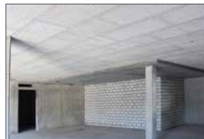
Dämmplatte mitbetoniert
