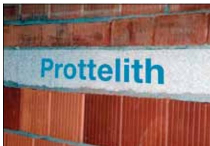
Deckenstirndämmung keine Stirnschalung nötig
