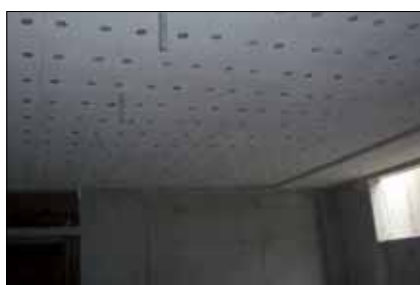
Dämmplatte gedübelt / geschraubt
